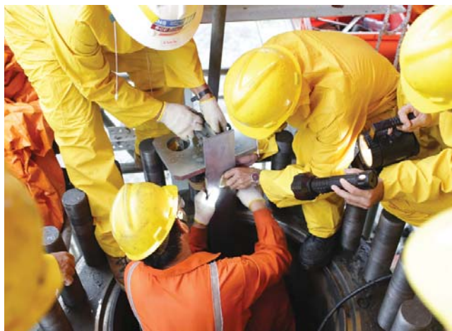
Công tác bảo dưỡng lớn được hoàn thành sớm hơn 18,5 giờ so với kế hoạch đề ra. Ảnh: NCSP
