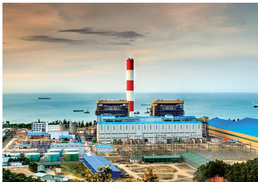
Nhà máy Nhiệt điện Vũng Áng 1. Ảnh: PV Power
