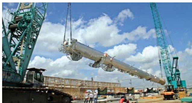
Tháp tách methane, ethane được lắp đặt thành công. Ảnh: PV GAS
