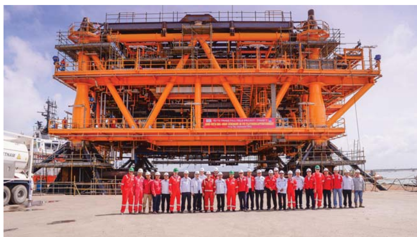
Khối thượng tầng giàn bơm ép khí Sư Tử Trắng được hạ thủy thành công. Ảnh: PTSC
